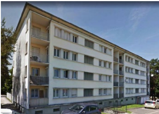
Avant travaux bâtiment sis 5 et 7 rue des écoles
