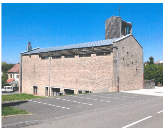
Eglise Sainte-Thérèse avant travaux
