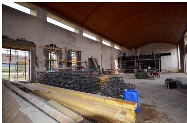
Pendant les travaux
