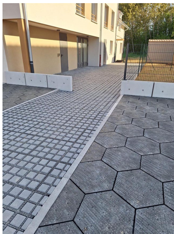
Voie pour piétons et stationnements à Montreux-Château (90)
