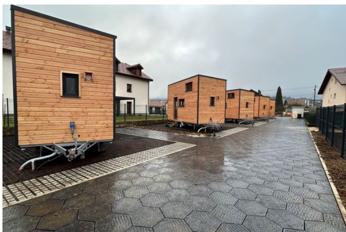
Voies et stationnement à Pontarlier (25)
